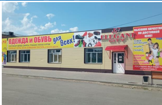
Реконструкция нежилого помещения под торговый объект ИП Давыдов А.Н.
