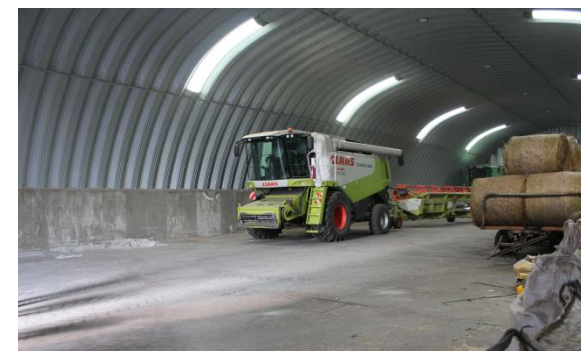
Строительство двух ангаров для хранения техники КФХ Дроздаков А.А.
