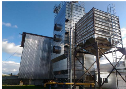
Строительство зерносушильного комплекса ИП Глава КФХ Генералов Н.Н.
