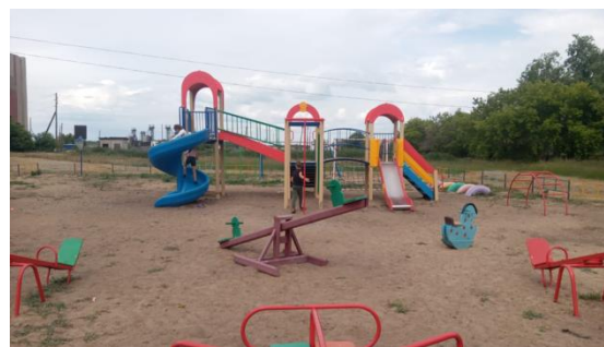
Строительство детской игровой площадки в с. Куломзино
