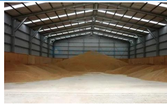
Строительство склада для хранения сельскохозяйственной продукции ИП Глава КФХ Новиков А.И.
